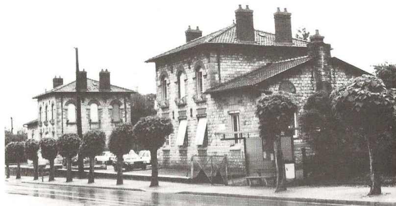
Façade de la " Maternité Boucicaut " de Chalon.
